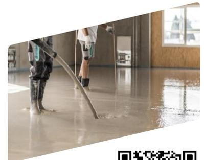
Le réchauffement, en plus de permettre une recouvrabilité rapide, sert aussi à abaisser la tension de la chape. Pour ce faire, respectez la fiche KBS «conditions spéciales pour les chapes chauffantes» sur notre site web [www.kbs-ag.ch](http://www.kbs-ag.ch) ou en utilisant le code QR :
